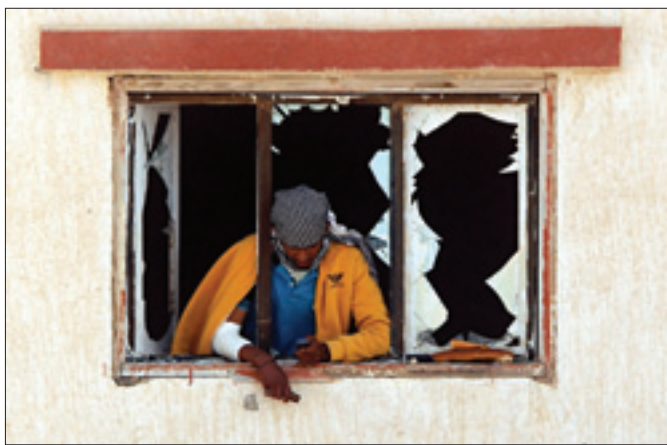
Un'abitazione danneggiata dai combattimenti ad Ajdabiya (Reuters)
